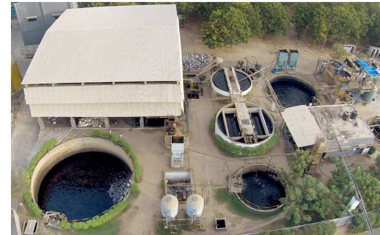
Effluent Treatment Plant (ETP)
